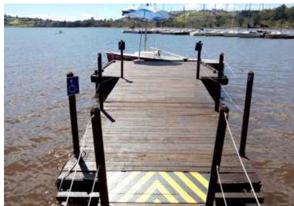
Figura 1. Píer onde será instalado o transferidor
